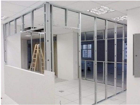
Drywall Construction
