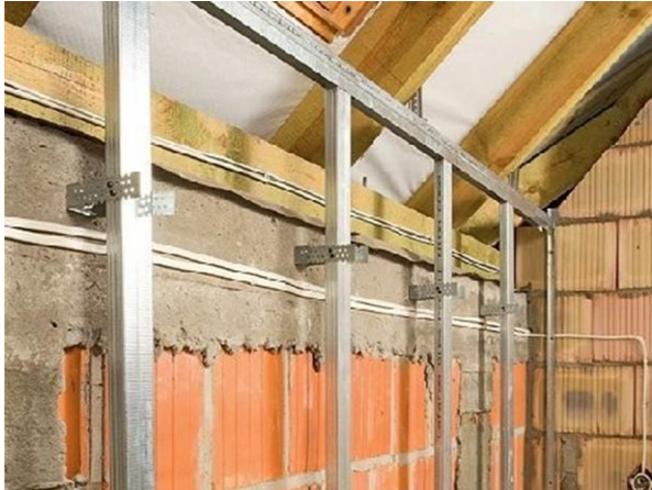
Drywall Construction
